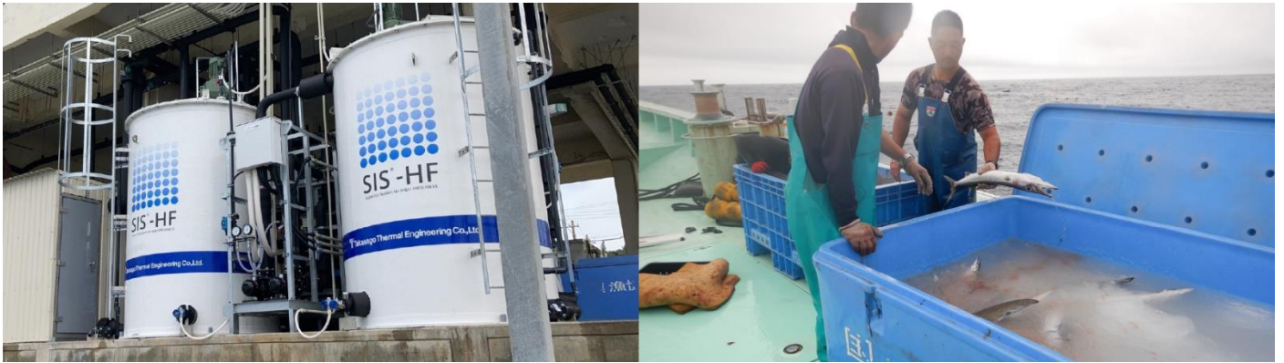
SIS-HF® 国頭漁業協同組合での設置状況／船上でのシャーベットアイス利用状況
